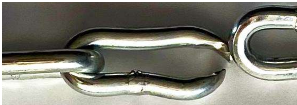
Рис. 5 – Зруйнована ланка ланцюга
