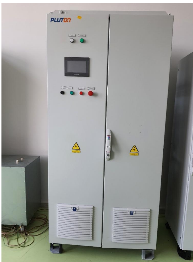
Рисунок 2. Зовнішній вигляд обмежувача напруги ОНТр-450
