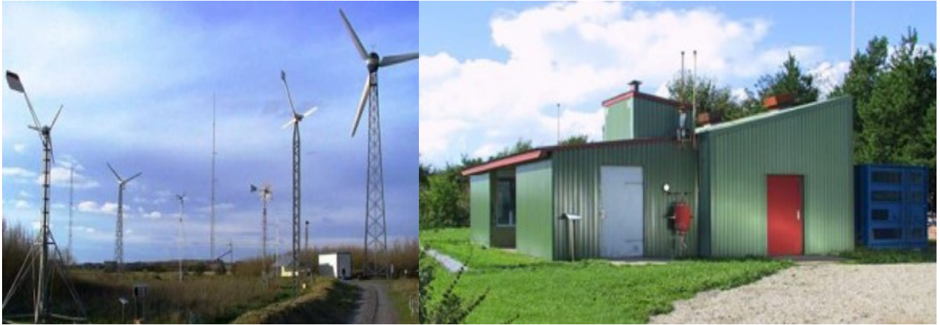
Рис. 2. Перша в Європі вітроводнева станція у Фолькецентрі
