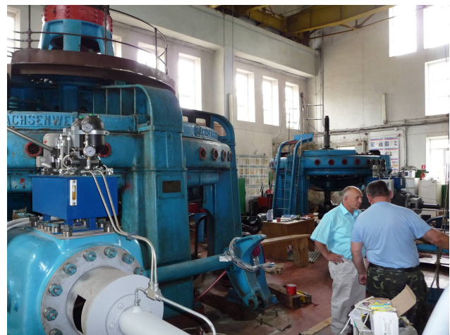
Рис. 3. Машинна зала Сабарівської малої ГЕС (Потужність 1400 кВт, р. Південний Буг, м. Вінниця).
